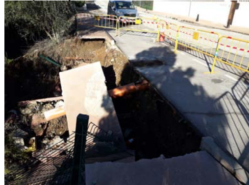
ACERADO EN AVENDIA DEL CORTIJO: rotura y desprendimiento de acerado.
