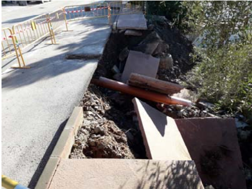
ACERADO EN AVENDIA DEL CORTIJO: rotura y desprendimiento de acerado.
